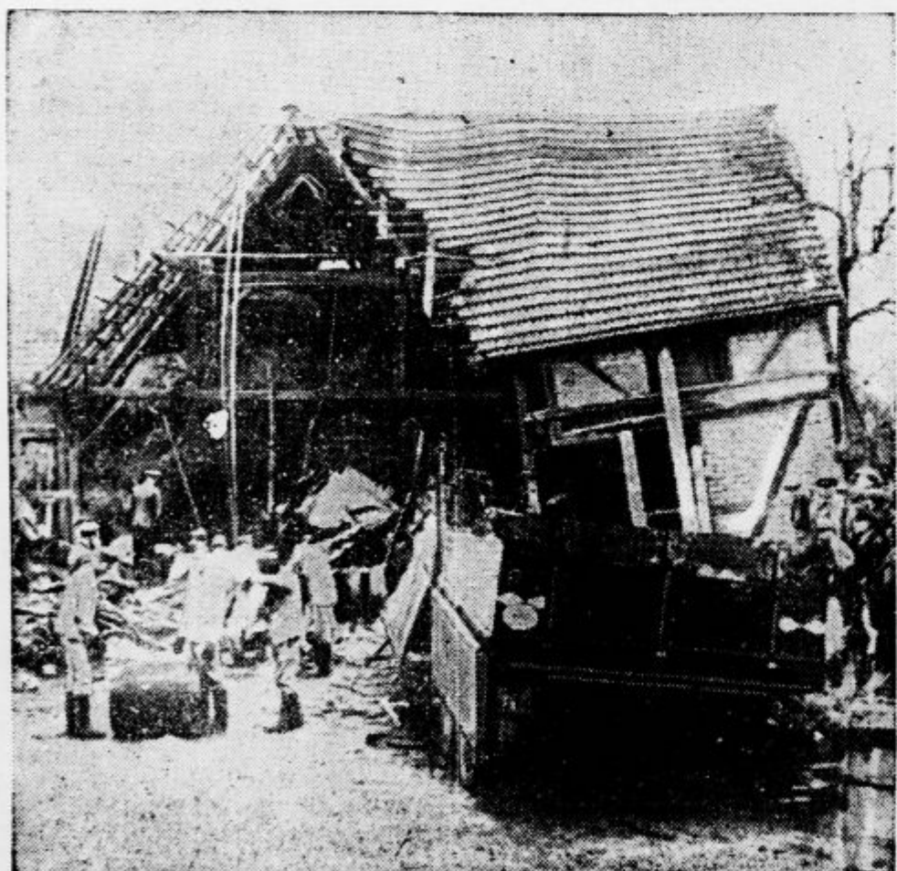
V Lohru am Mojn je neki avtomobil zadel v hišo ter jo tako stresel, da se je podrla. Na sliki vidimo položaj stavbe po katastrofi
