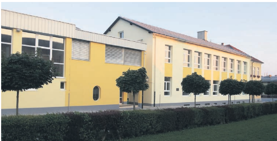
Izbrani gradbeni izvajalec je glavno obnovitvenih del opravil med poletnimi počitnicami, tako so se učenci septembra vrnili v polepšano šolsko poslopje, ki bo v prihodnje energetske precej varčnejše in s tem prijaznejše do vseh, ki bodo v njem delali. (Foto: Občina Prebold)
