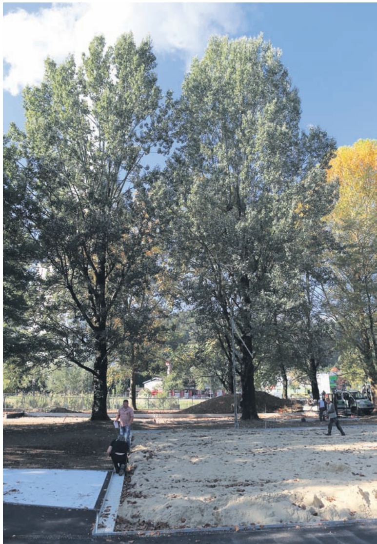
Na Trgu svobode v Šoštanju so v teku zaključna dela, trg pa počasi že dobiva končno podobo.
