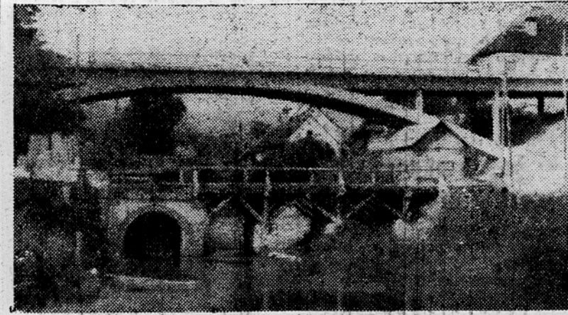
Novi most nad Lahinjo v Crnomlju
