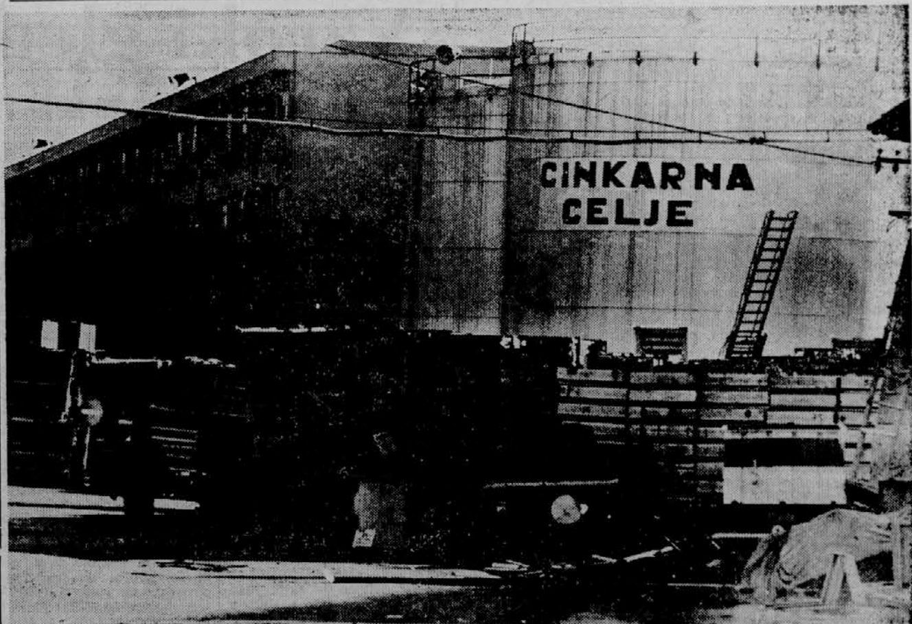
PROSTORA PRIMANJKUJE — Te dni, ko se razvija promet v koprskem pristanišču kot še nikoli doslej, je vsak meter prostora med skladiščem založen z različnim blagom, ki čaka, da ga bodo naložili na ladje ali pa na vagonne in ga po železnici prepeljali do naslovnikov. Foto: E. Selhau
