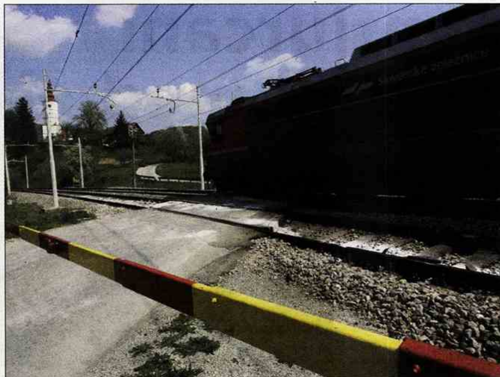
Tovorni vlak, ki je vozil iz smeri Rimskih Toplic proti Laškemu, je 55-letnega delavca povozil med opravljanjem vzdrževalnih del na tirih.
