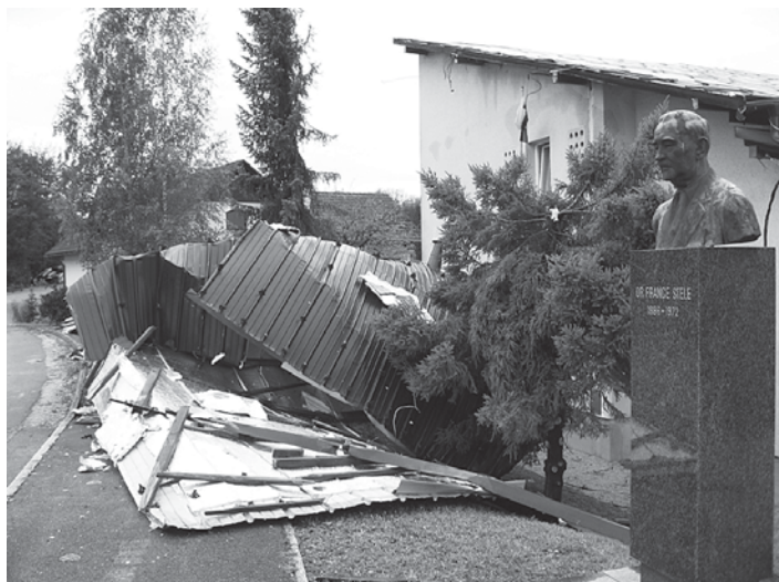
Zvita pločevinasta streha pred tunjiško šolo
