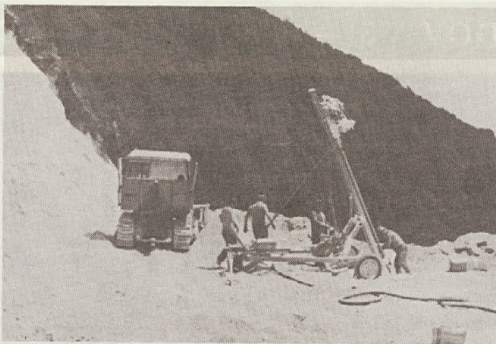
Globoko vrtanje z lafeto v peskokopu Soteska (Foto: ing. D. Kure).
