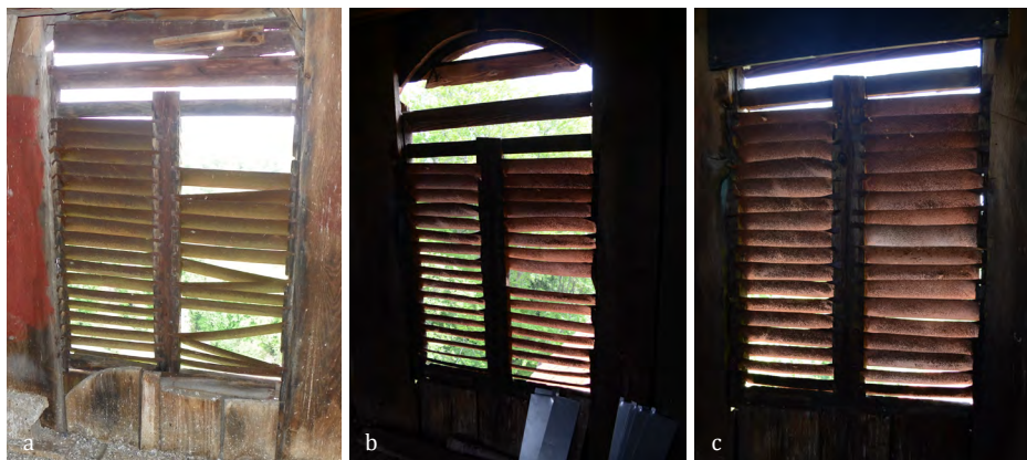
SLIKA 14. a) - b) Polkna na zvoniku so pred izvedenimi ohranitvenimi ukrepi omogočala dostop golobom (foto: Jasmina Kotnik, Nika Krivec), c) z deščicami dopolnjena in preurejena polkna pa omogočajo le prehod netopirjem (foto: Nika Krivec).
