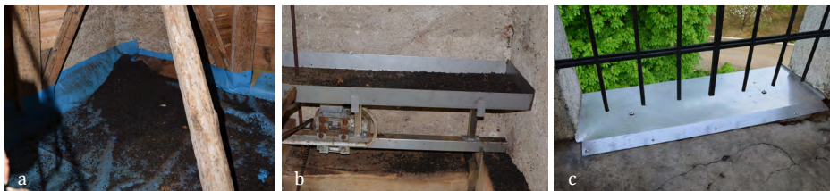
SLIKA 8. a) Izvedeni ukrepi so zadržali večino gvana v predelu nad zvonovi, b) tudi polička nad mehanizmom za zvonjenje nudi ustrezno zaščito, c) zamenjane odkapne police (foto: Simon Zidar).
