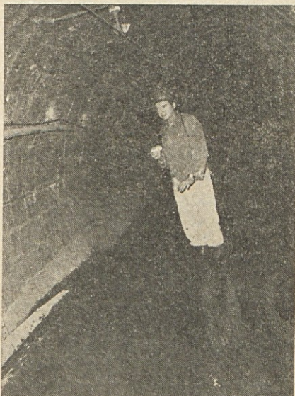
Stane Marković v progi med jaškom A in polniščem na VII. obzoru jame Hrastnik. Po progi teče okrog 4 m 3 /min. vode po vdoru vode na delovišču prečnice, ki jo odpiramo proti severu za povezavo z vpadnikom iz zveznega obzora na VII. obzor. Foto inž. A. Bregant
