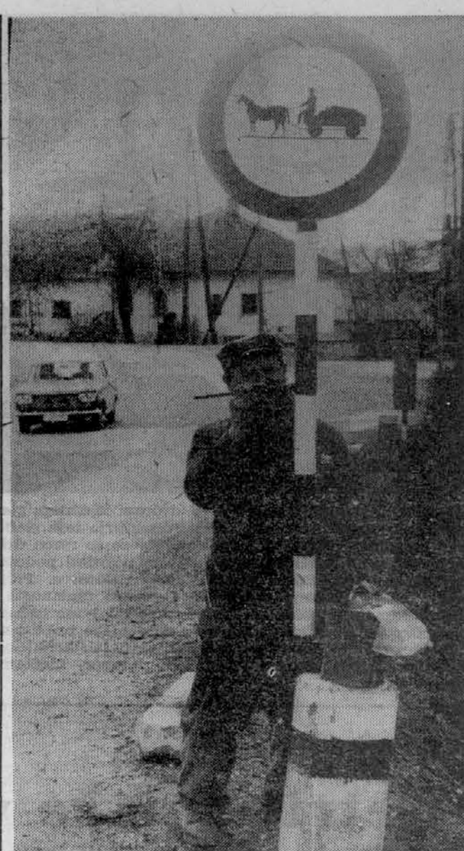
REDNO VZDRŽEVANJE — Dnevi postajajo vse daljši in začeli smo tradicionalna spomladanska dela, ki naj popravijo, kar je poškodovala zima. Delavci Cestnega podjetja v Ljubljani so začeli barvati prometne znake na vseh ljubljanskih vpadnicah. Bliza se tudi turistična sezona, zato je nujno storiti vse, da obdrži Ljubljana slobode belega mesta. Do maja bodo delavci cestnega podjetja, ki skrbijo za redno vzdrževanje teh znakov, prebarvali več kot 3.000 prometnih znakov na tako imenovanem ljubljanskem cestnem križu.
