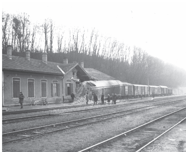
Porušeno postajno poslopje Ormož zaradi vteka vozil 19. marca 1976. Hrani: Karel Rustja.
