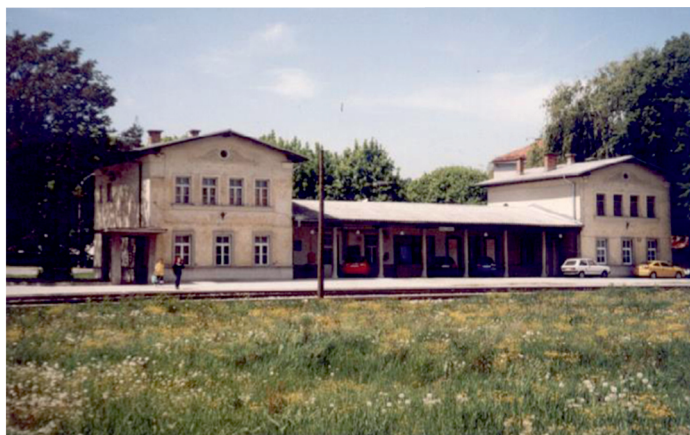
Postajno poslopje Ljutomer. Vir: Slovenske železnice.
