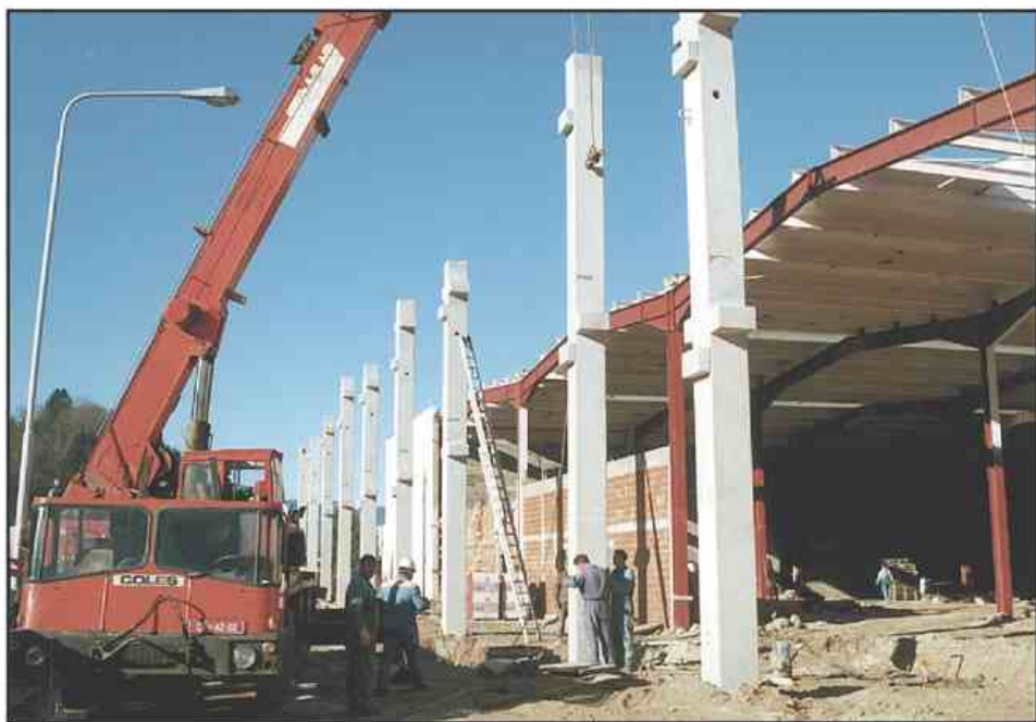
Nova Galvana že stoji. V prvih decembrskih dneh bodo začeli vanjo nameščati opremo, naložbo naj bi sklenili do aprila prihodnje leto. V celoti bodo obnovili tudi čistilno napravo.
