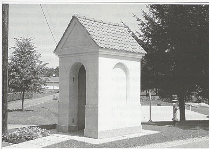
Gradbena dela na spominski kapelici so zaključena.
