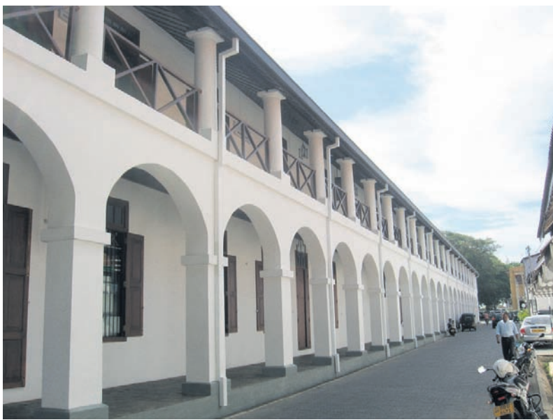
Trdnjava v mestu Galle je spomenik svetovne kulturne dediščine. Po cunamiju so poškodovani deli obnovljeni.
