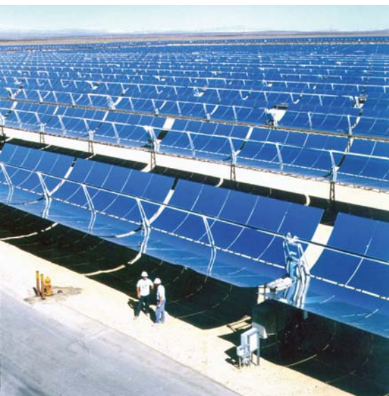
Slika 5: Vakuumski sončni zbiralniki za sprejem koncentrirane svetlobe. Električne centrale s tisoči zrcal so v puščavskih predelih vse pogostejše.
