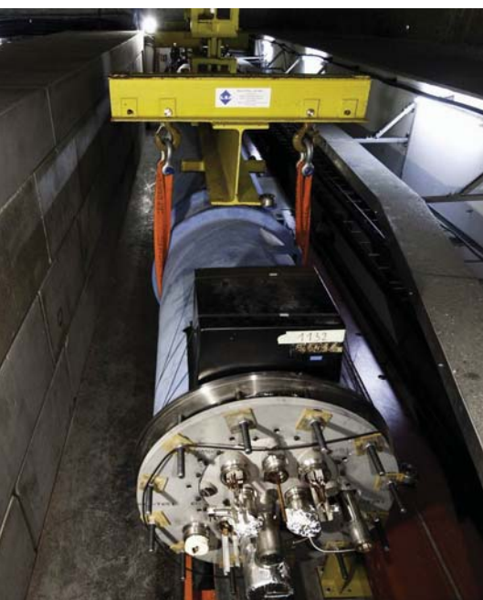
Slika 8: Največji pospeševalnik energijskih delcev lahko deluje pri temperaturi tekočega helija zaradi skrbno načrtovane vakuumske izolacije.
