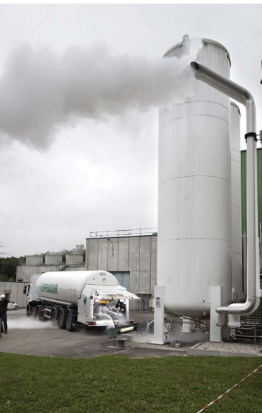
Slika 10: Transport in skladiščenje utekočinjenih plinov potekata zaradi učinkovite vakuumske izolacije ob minimalnih izgubah.
