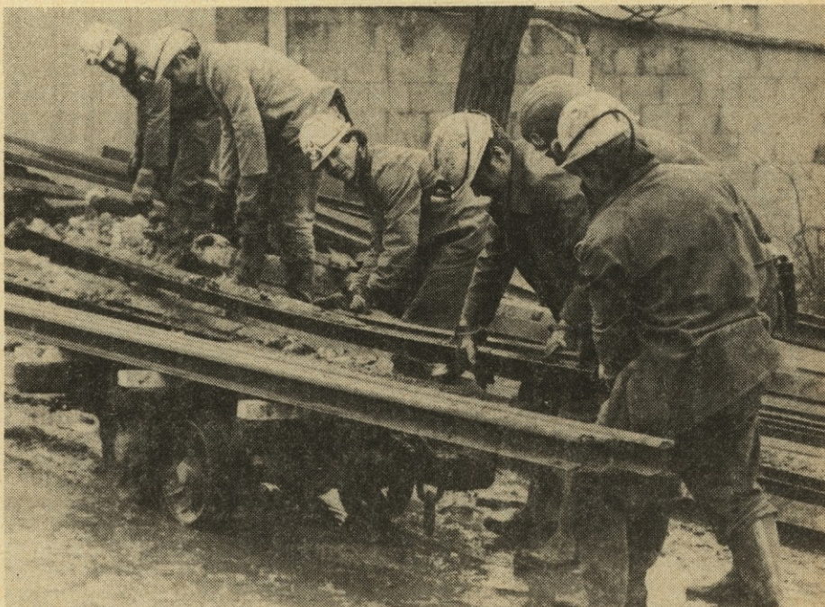
Tračnice niso bile nikoli lahke. Nakladanje le—teh na „cicko“ za prevoz v jamo Hrastnik. (Foto: B. Klančar)
