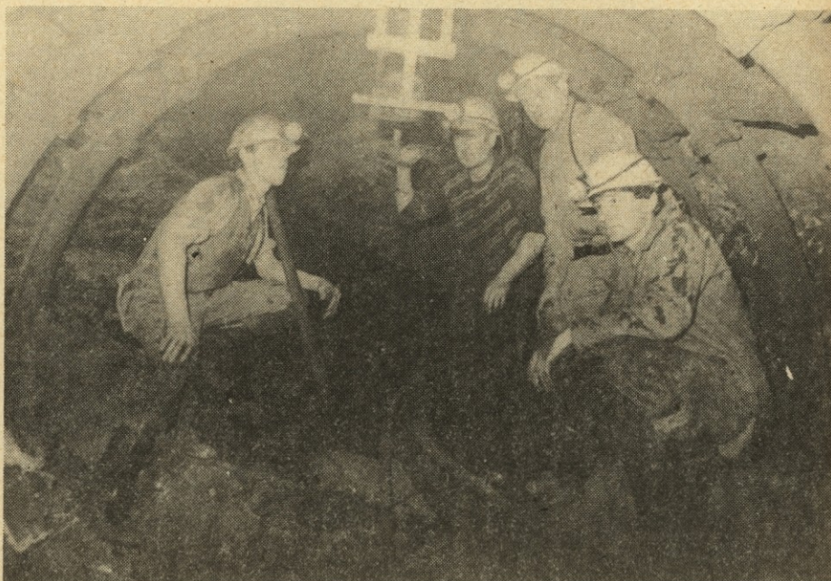
Skupina rudarjev do RGD — tozdr RIG v jami Ojstro, rudnik Hraštnek, pri izdelavi glavne izvozne proge v dolomitu na koti 150. (Foto: J. Kirič)
