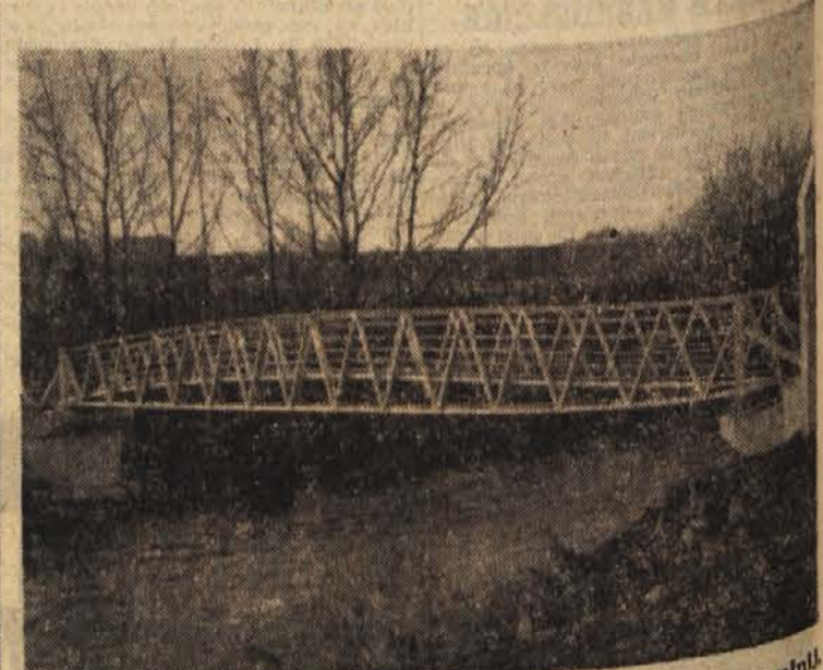
V sodobni tehniški dejavnosti se čedalje bolj uveljavlja aluminij. Zlato ki so ga že pred desetletji označili za kovino bodočnosti. Zdaj ga uporabljajo že v številnih industrijskih panogah, gornji posnetek pa kaže most čez angleško reko Ebbw v južnem Walesu; pri gradnji so uporabili izključno aluminijasto konstrukcijo.
