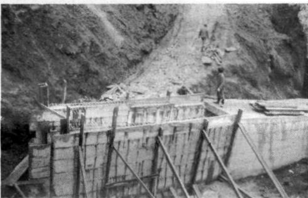
Na sliki: Del ceste, kjer potekajo najzahtevnejša rekonstrukcijska dela
