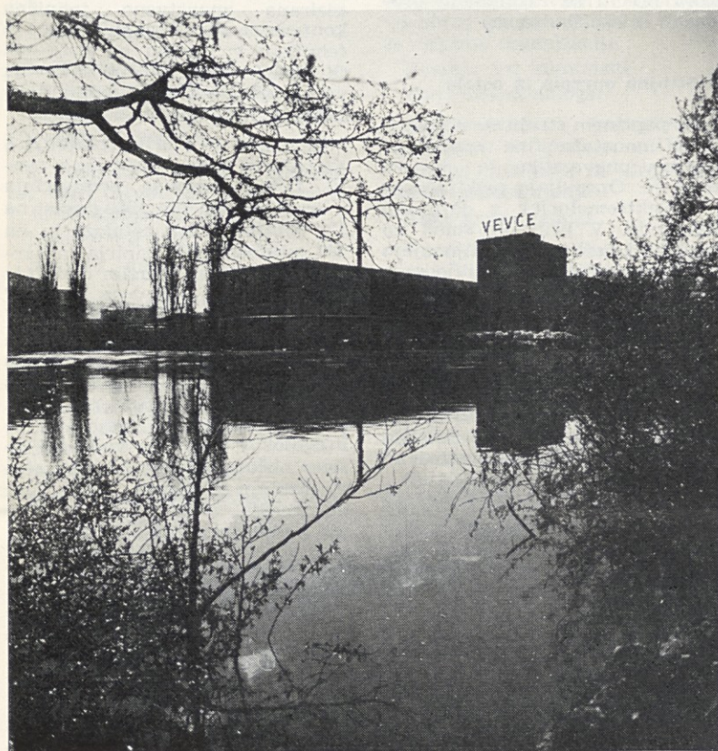
Pogled na novo stavbo V. PS in premaz
