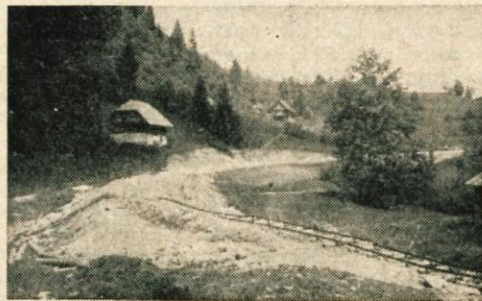
Na gradilišču ceste Gorjuše - Koprivnik je tiho
