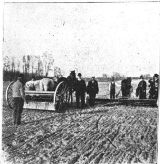
Podoba 77. (izvir) Trosilo za gnojila in semena „Frey“ med delom ter ročna setev deleža c (lahko kosmato seme).
