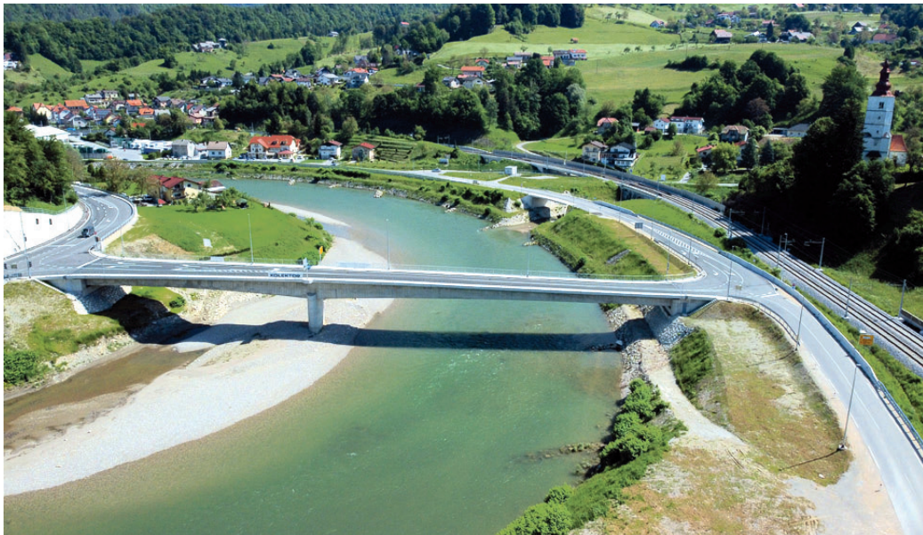
Nov most čez Savinjo v Marija Gradcu je bil del projekta nadgradnje železniške proge med Celjem in Zidanim Mostom.
