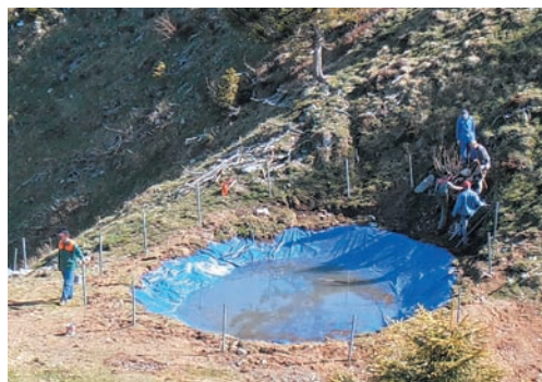
Popravljen zbiralnik vode.
