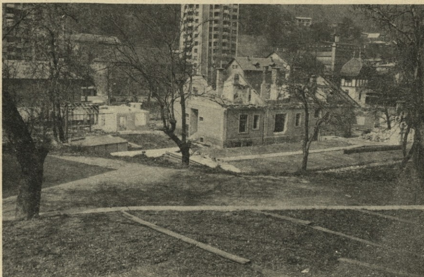
Od uprave RGD so ostali le še temelji. Tudi poslopje uprave separacije že rušijo (foto Anton Bregant)
