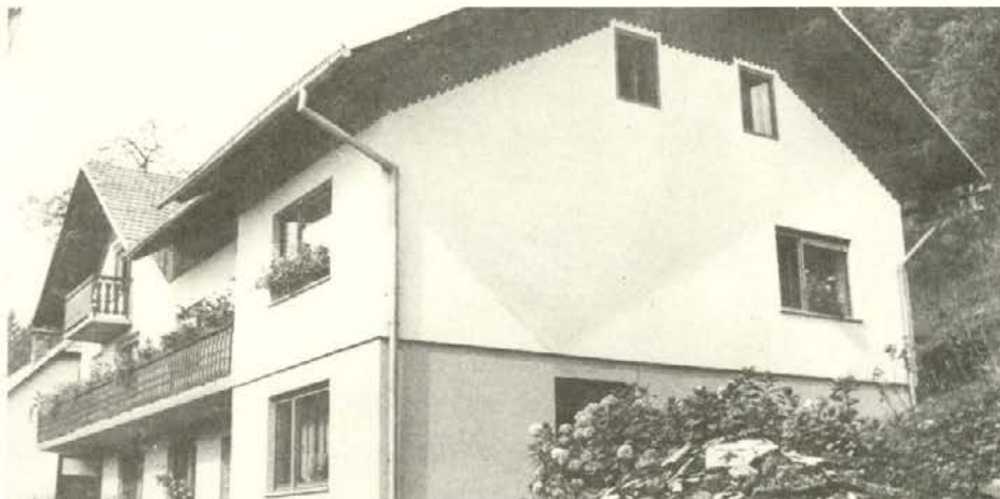
Takšna je nova hiša pri Zabernikovi
