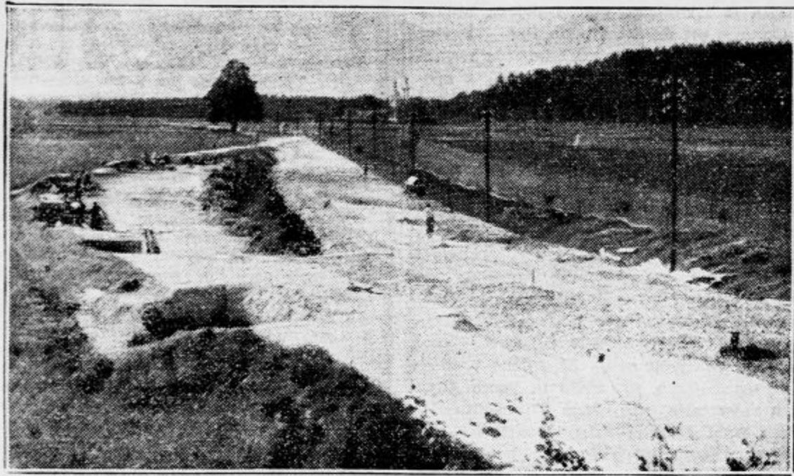
Korigiranje stare vijugaste ceste pred Jeperco. Levo stara, desno nova cesta
