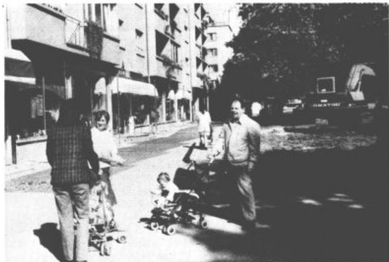
Bodoči center Velenja je pravo gradbišče, ki nam sedaj še izgleda tuje. Končno oceno bomo lahko dali šele čez približno dva meseca, ko bo obnova predvidoma končana
