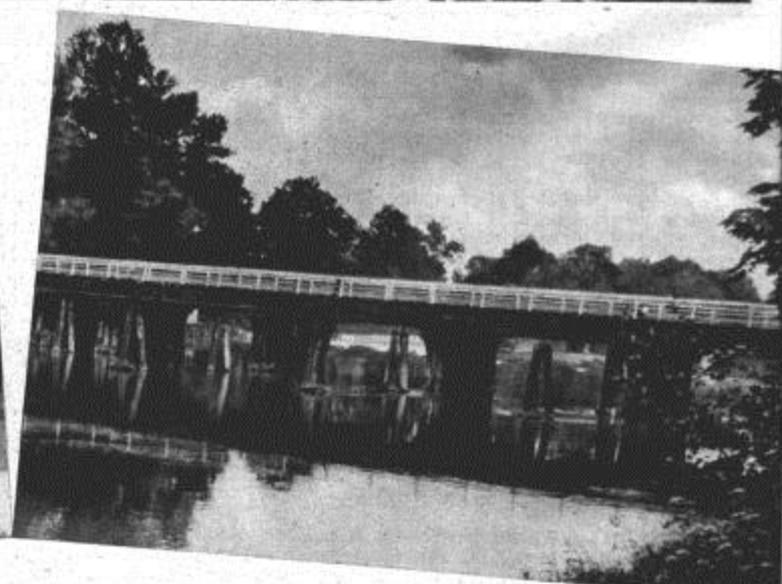
Die alte und die neue Reifebrücke in Reife, Oberschlesien. Da die alte Holzbrücke baufällig war und nur noch eine Belastung von etwa neun Tonnen aushielt, erbaute die Provinzialverwaltung Oberschlesien eine neue 102 Meter lange Betonbrücke, die in Zukunft den Verkehr auf der Strecke Breslau—Brieg—Reife—Leobschütz—Ratibor vermitteln soll Sobotzki, Reife
