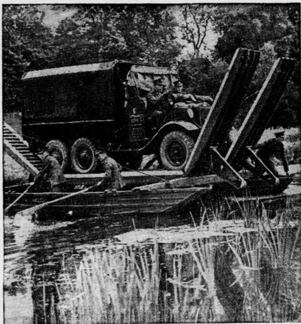
Angleška armada je dobila v zadnjem času novo vrsto pontonskega mostu, ki je zlasti pripravljen za prehod motoriziranih čet čez reke. Most ima priprave, ki omogočajo prav naglo prekrcavanje motornih vozil (slika)
