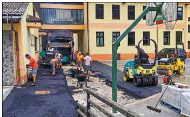
V Lučah so prenovili dotrajan asfalt ob šoli in športni dvorani.
