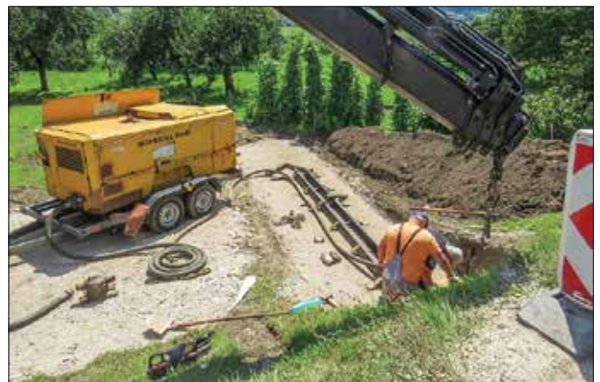
Dela za izvedbo meteorne kanalizacije v Dobletini so bila dokaj zahtevna. (Foto: Igor Solar)
