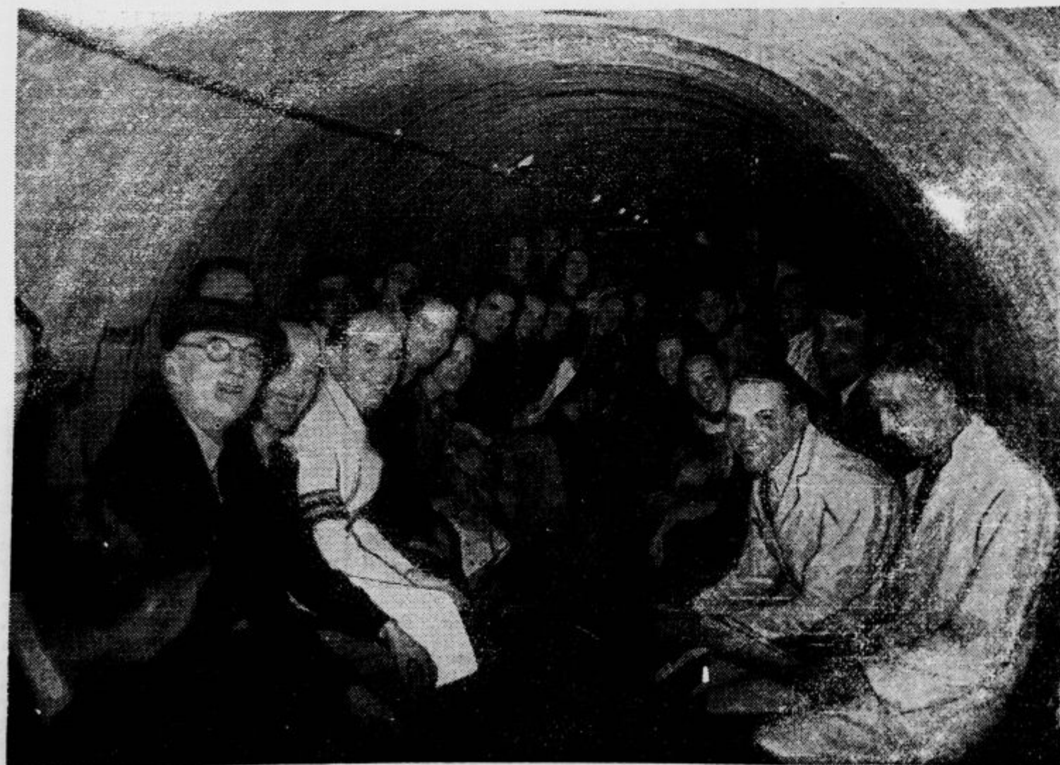
Vedno več angleških industrij gradi vzorna zaklonišča zoper zračne napade za svoje nameščenice. Slika nam kaže enega izmed varnih predorov, ki jih je zgradila neka telefonska tovarna zunaj Londona za svojih 6000 delavcev. Predori so zaprti z jeklenimi vrati in pred njimi so še močni betonski štiti
