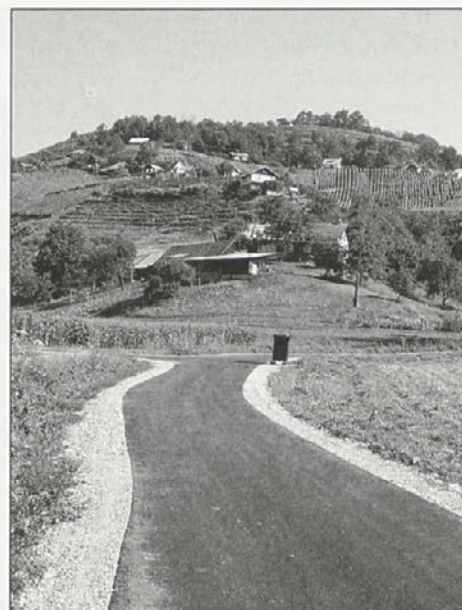
Cesta v Kojuhovju – II. del moderniziranega odseka
