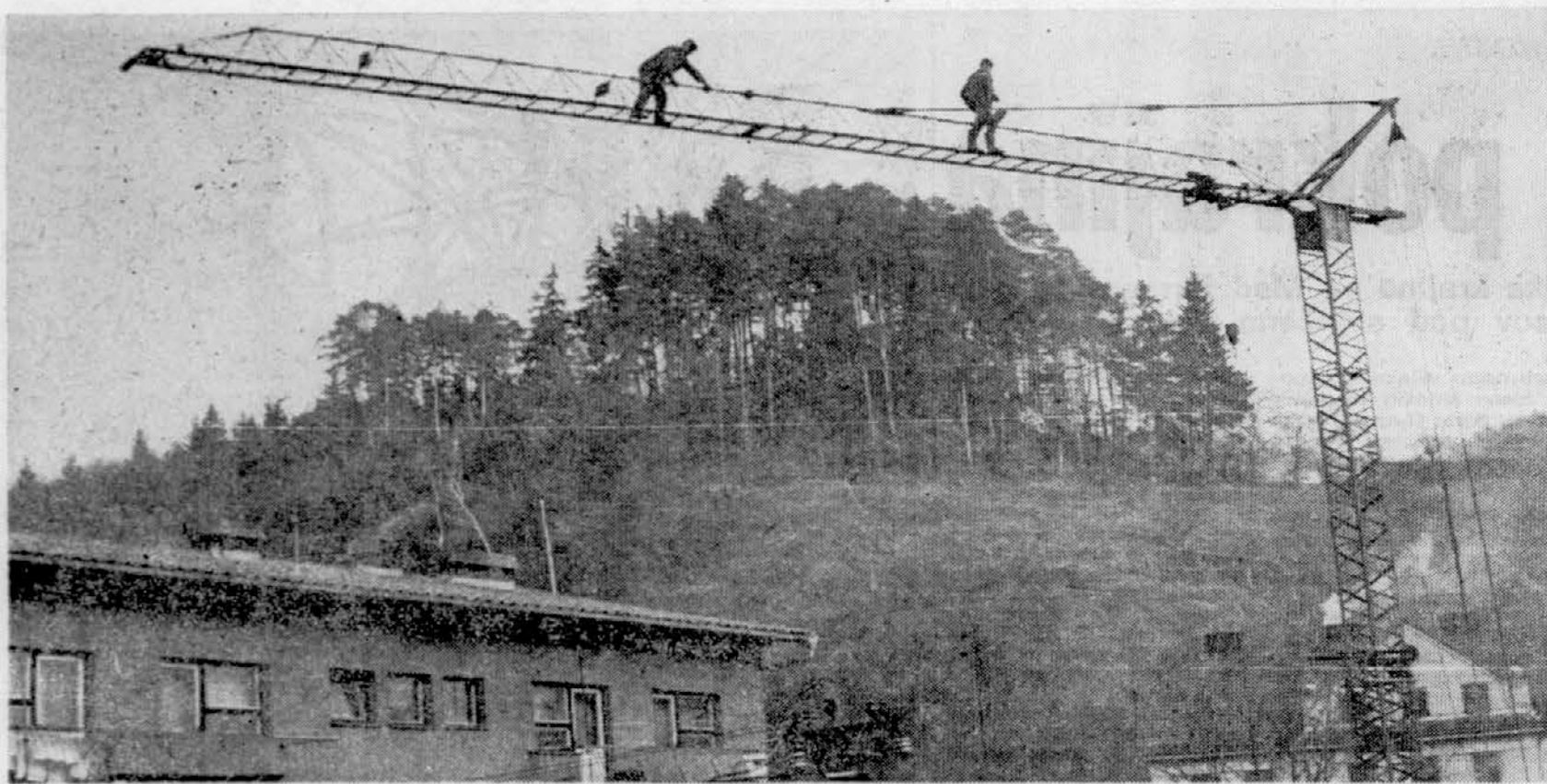
NE POZNATA STRAHU IN VRTOGLAVICE — Fotografija je nastala ob gradbenih delih pri regulaciji potoka Planinsčica v Trbovljah. Dela opravlja gradbeno podjetje »Zasavje« iz Trbovelj. Za montažo in vzdrževanje takšnega dvigala je potreben pogum delavcev-strojnikov. Vrtooglavi in strahu ne smeta poznati. Elegantly se sprehajata po nosilcu dvigala, ljudem spodaj, ki so ju opazovali, pa je zastajal diha. Foto: Franci Bartol
