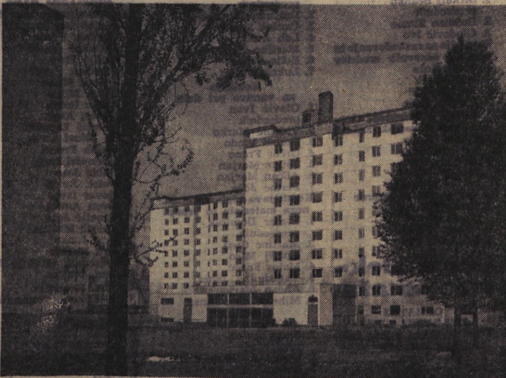
Stanovanjsko naselje v Mariboru s šestimi desettropnimi stolpnici, za katero je naše podjetje projektiralo in izvedlo vrsto zahtevnih instalacij
