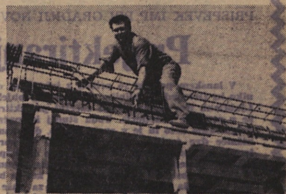
Anton Pristov pri instalaciji na gradbišču v Libiji
