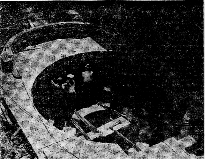
V strojnihi hidrocentrale Moste je vse pripravljeno za montažo velikih turbin.
