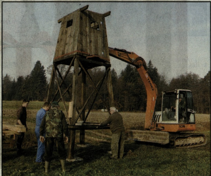
Preža je bila hitro naložena in postavljena s pomočjo tehnike
