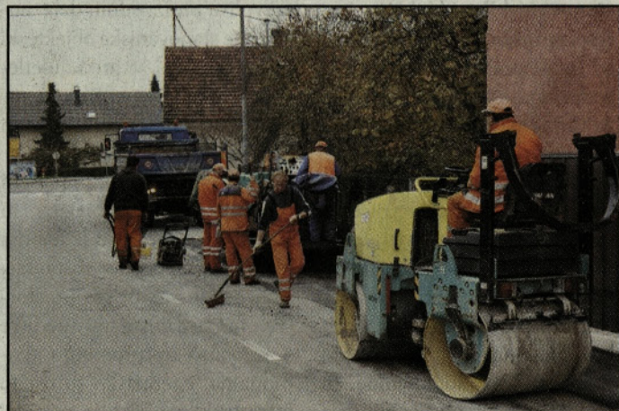
Med asfaltiranjem zadnjih nekaj metrov bankin v Dolenji vasi pred križiščem
