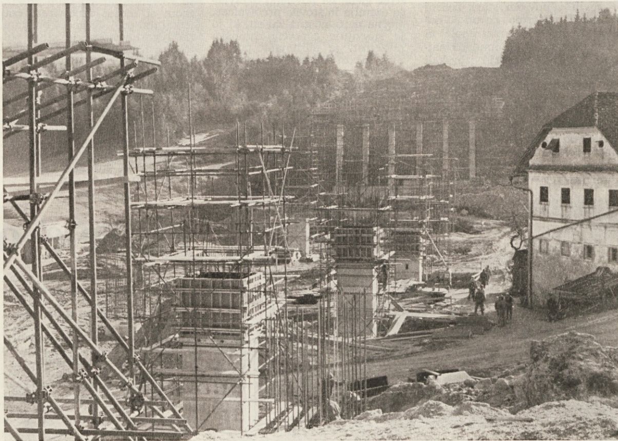
Gradnja nove moderne štiripasovne ceste od Vrhniko proti Postojni dobro napreduje. Graditelji so tudi z vremenom več kot zadovoljni
