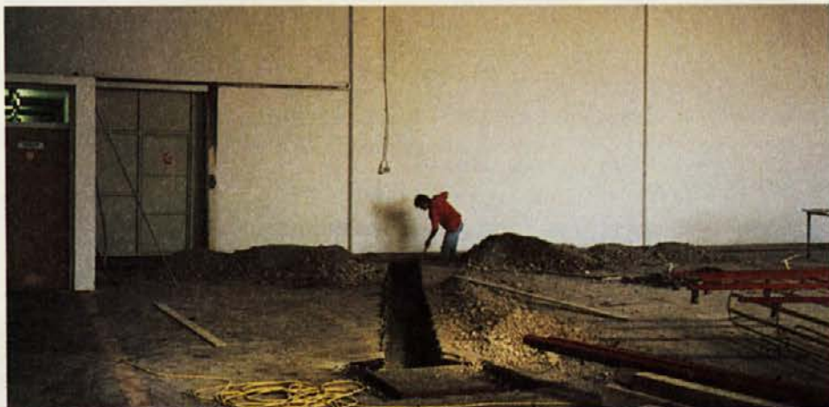
Popravilo temeljev v proizvodnji
