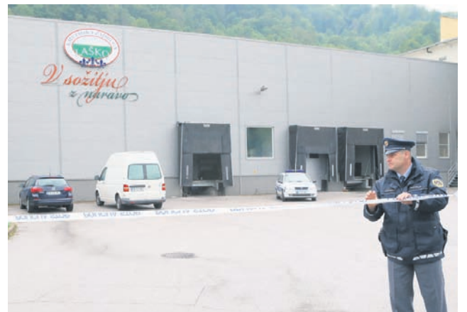
Dostop v notranjost stavbe, kjer je gorelo v ponedeljek zvečer, je bil dan kasneje onemogočen.
