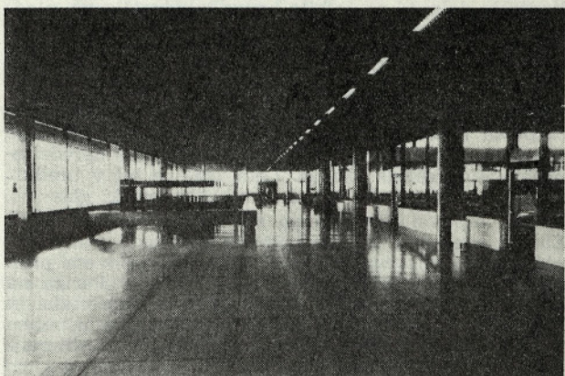
Sl. 3. Z dvojno osteklitvijo različnih prostorov in dvoran ostane temperatura sten v glavni dvorani vedno nad rosiščem. S tem se tudi prepreči nastajanje kondenza
