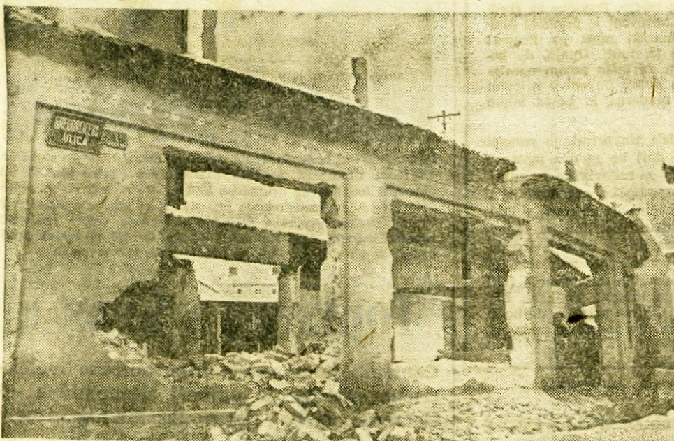
V Kranju so pričeli rušiti prtilične stavbe za »Staro pošto«. Na tem mestu je v načrtu gradnja trgovskega centra. V prvi fazi del bodo porušili le nekaj stavb ter na praznem prostoru začasno uredili parkirni prostor. Računajo, da bodo pričeli z gradnjo trgovskega centra približno čez dve leti
