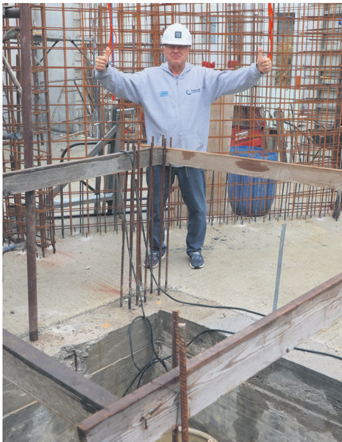
Dvigalo najprej ni bilo predvideno v hostlu. Ko je načrt videl pokojni Bora Đorđević, se je začudil. Dušan Konda stoji pred odprtino za dvigalo. Tam bo pisalo: »Borin lift.«
