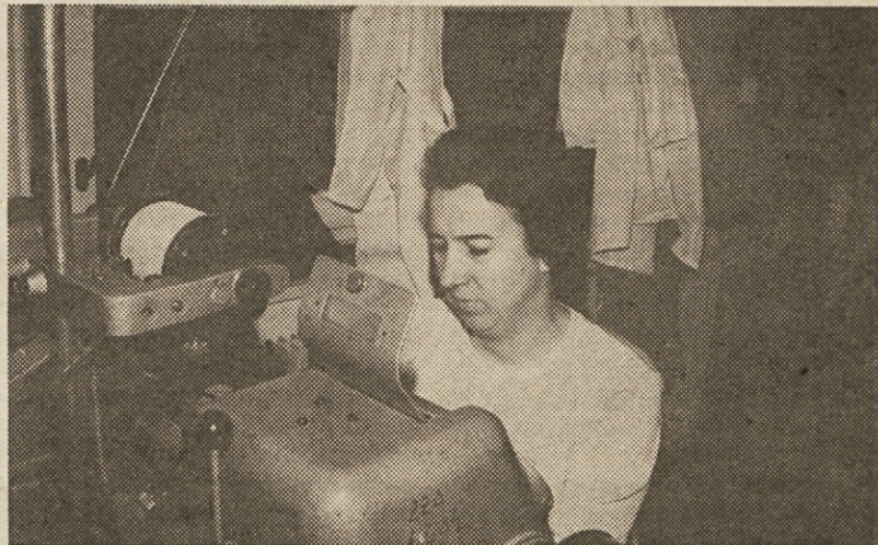
TOZD SPECIALNI ELEMENTI LJUBLJANA: Mihaela Šušteršič ima zahtevno delo, navija specialne transformatorje.
