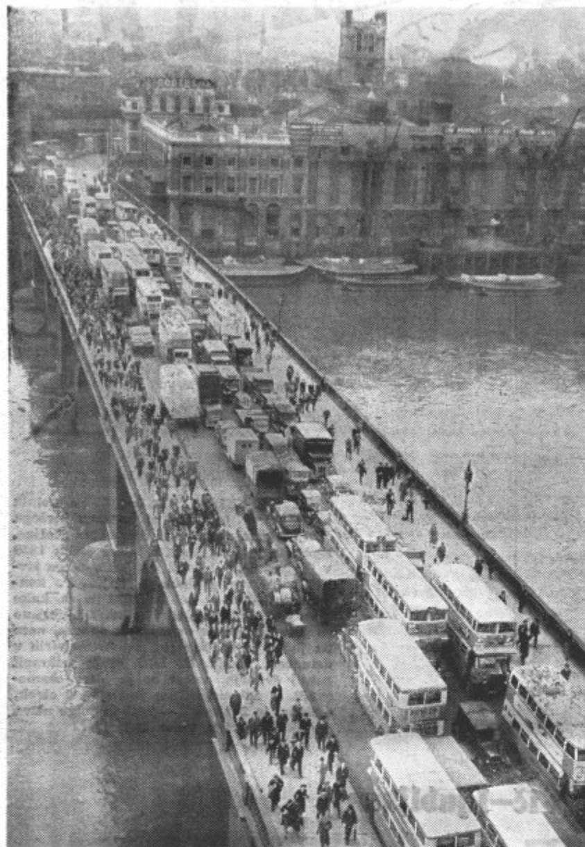
PROMET SE JE USTAVIL. Velemestni promet je občutljiv stroj, ki ga lahko najmanjša malenkost spravi iz obrata. Slika nam kaže prometno motnjo na nekem mostu v Londonu, ki je nastala zavrlo tega, ker se je pri nekem požaru poškodoval električni vod
