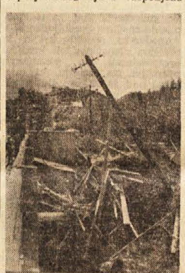
Deske, hlode, ostanke skednjev, brzojavne droge, vse je voda nagrmadila ob betonski zid
