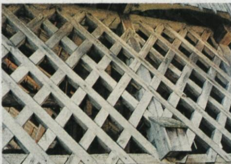
V nadstropnem delu topolarja je mrežasta konstrukcija - križi.
