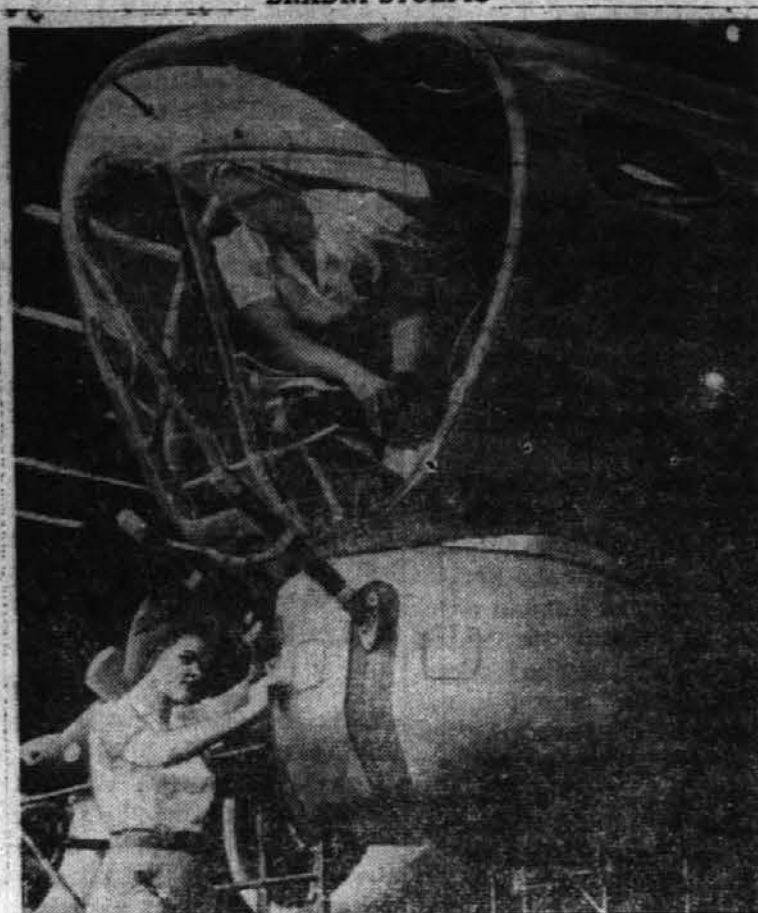
Tukaj vidimo iz neposredne bližine posneti stolpič, ki je kakor brada na novem Boeing B-17G bombniku, katere izdelujejo v Lockheed-Vega tovarni, Burbank, Cal. V stolpiču, ki je pod datno kontrolo, sta pritrjeni dve strojni puški 30. kalibra, da odvračata napade od spredaj.
