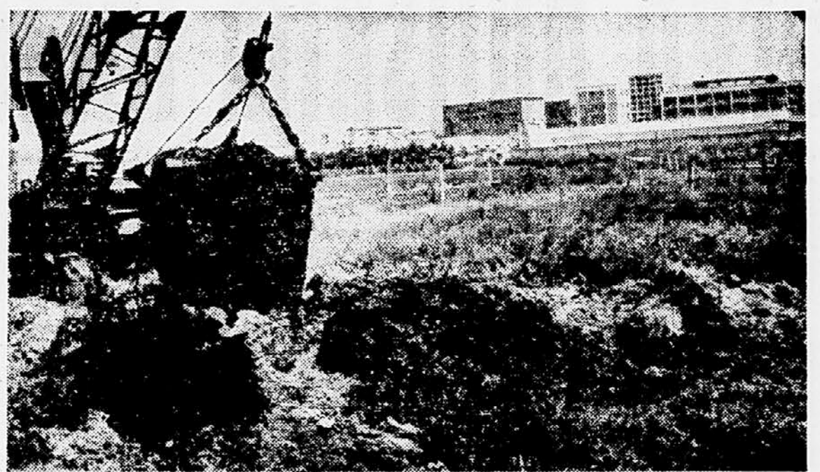
Delo bagra na semedelski depresiji. Dobro je videti zanemarjenost odvodnih jarkov, ki jih ni nihče čistil, odkar so bili skopani. (Tega je menda že 30 let.) Zaradi zaraščenosti sploh niso več mogli opravljati svoje funkcije. — V ozadiju Koper: Hotel Triglav in stanovanjski blok. Pred njima letni kino.
