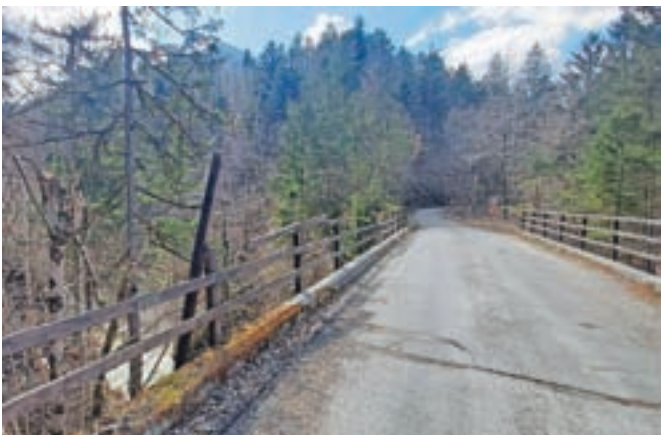
Menjavo ograje na mostu čez Kamniško Bistrico v dolini Korošice bodo opravili hkrati s prenovno mostu, ki se že pripravlja. / FOTO: JASNA PALADIN
