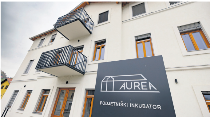
Obnova dotrajane in zapuščene zgradbe v podjetniški inkubator je znašala približno 1,3 milijona evrov, od tega je občina približno milijon zagotovila z evropskimi in državnimi sredstvi. (Foto: Nik Jarh)
